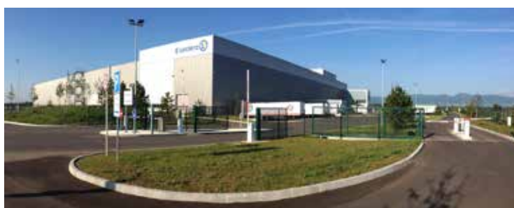
Entrepôt automatisé de Scapalsace à Niederhergheim
