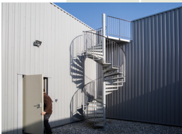
Figure 2. Accès en toiture © Albert Pereira pour l'INRS
